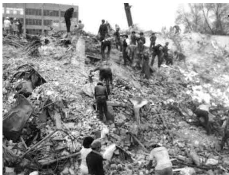
Remoción de escombros de la torre hospitalaria
