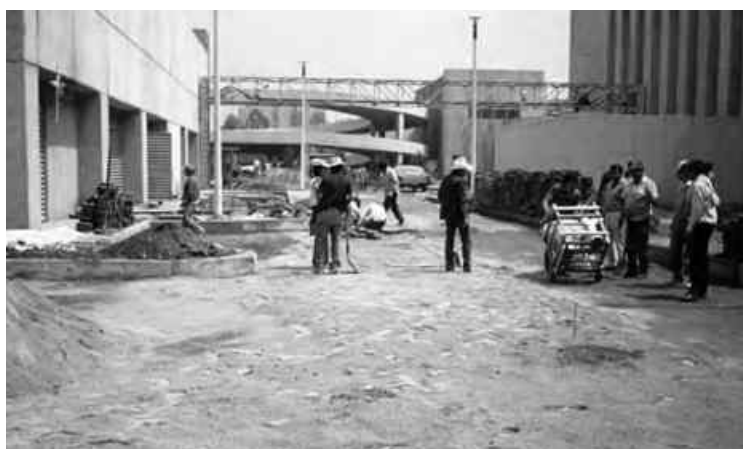
Construcción del Hospital Juárez de México
