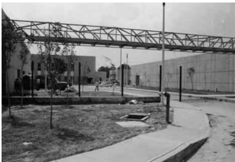
Construcción del nuevo hospital
