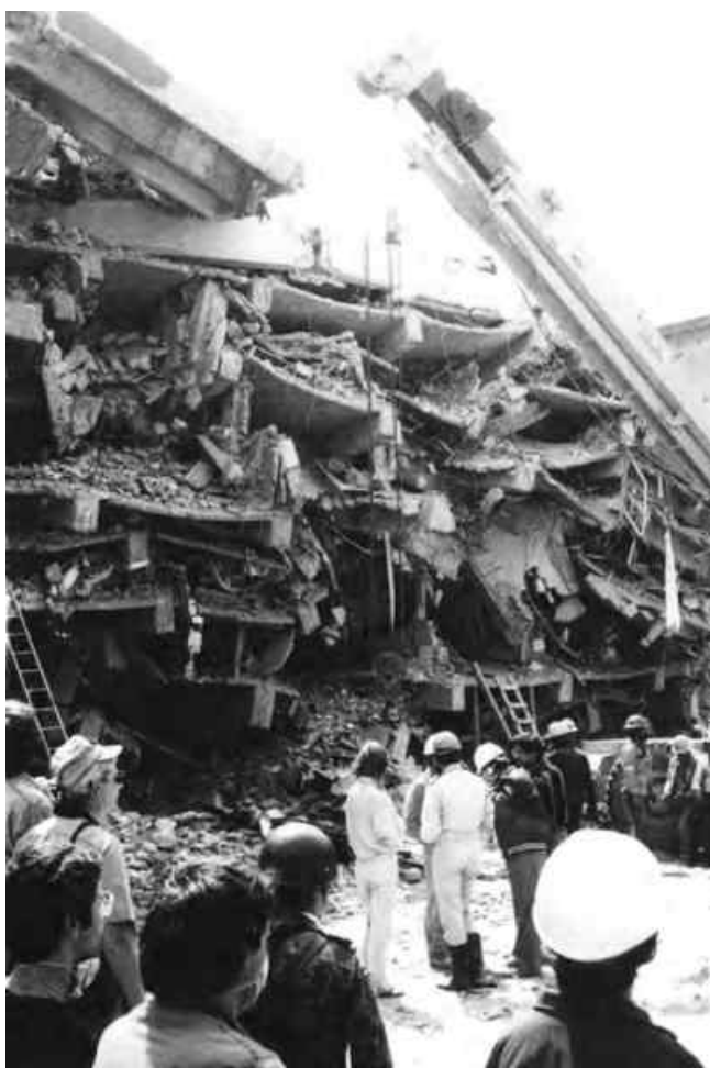
Derrumbe de la nueva torre del Hospital Juárez
