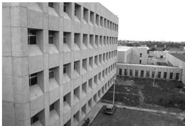
Construcción del Hospital Juárez de México
