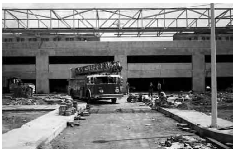
Construcción del estacionamiento
