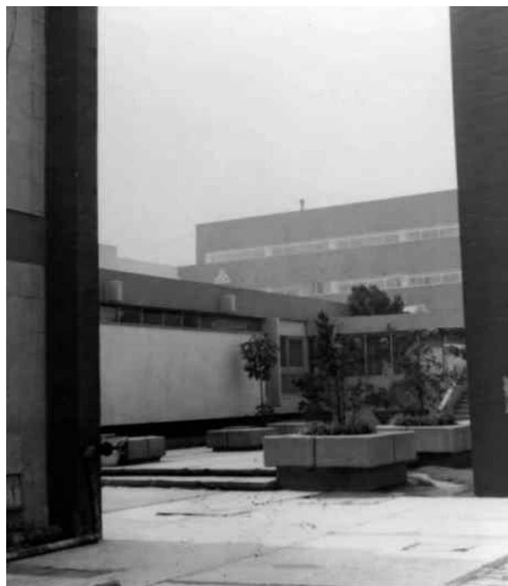
Costado de la torre del Hospital
