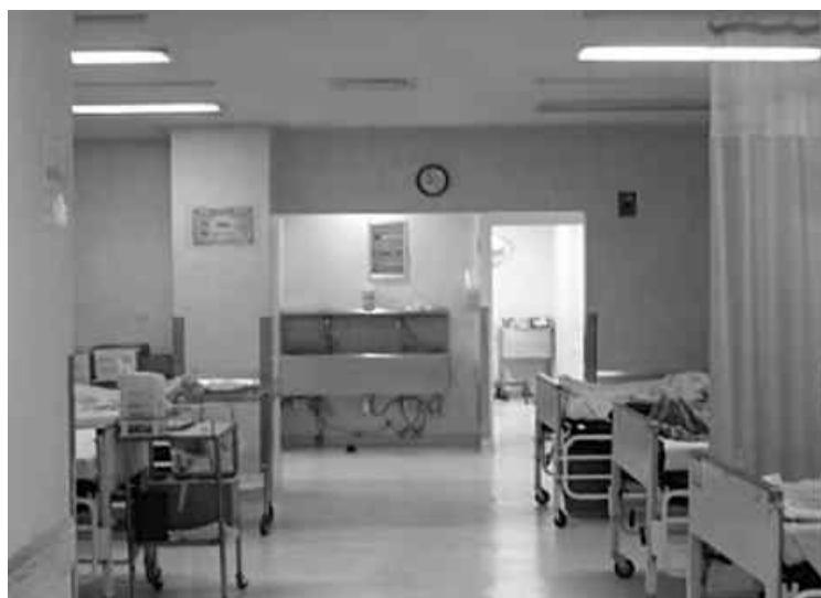
Unidad tocoquirúrgica rehabilitada
