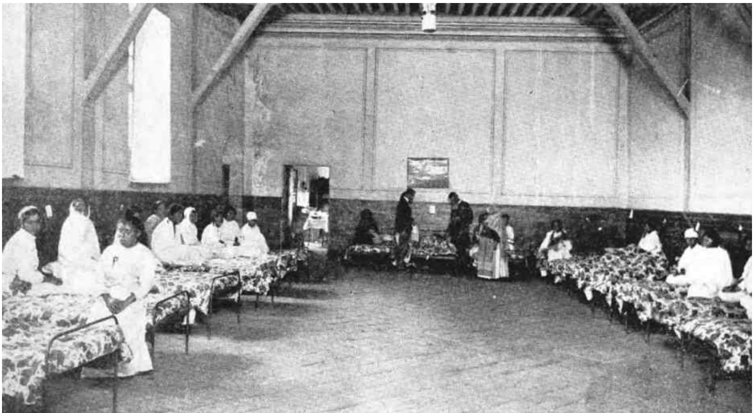
Una de las salas reformadas del Hospital
