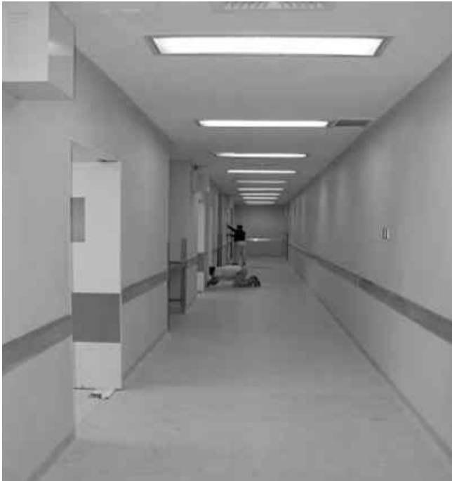
Pasillos de quirófanos en proceso de renovación
