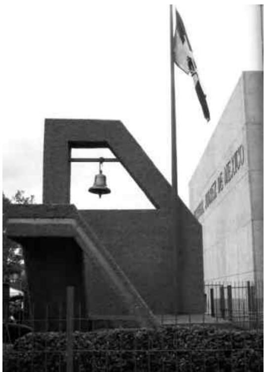
Detalle de la fachada del Hospital Juárez de México
