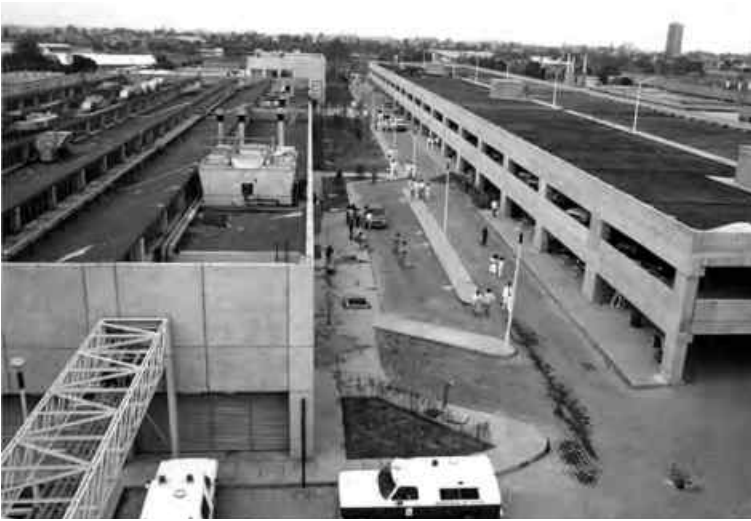
Edificio y estacionamiento del Hospital Juárez de México
