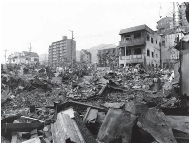
Figura 5. El centro de Kobe tras el sismo e incendio de 1995. Véanse las pesadas techumbres en el primer plano.
